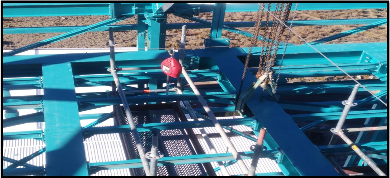
Foto: se realiza inspección a los puntos de anclajes y cuerdas de vidas instaladas por personal de EIE.
