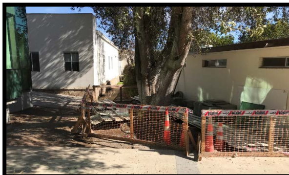
Instalación de barrera dura en el área de acopio de material y futuros trabajos de instalación de baldosa
