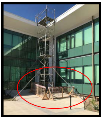
Instalación de barrera dura en el acceso a techumbre. Esta área es solo para personal autorizado
